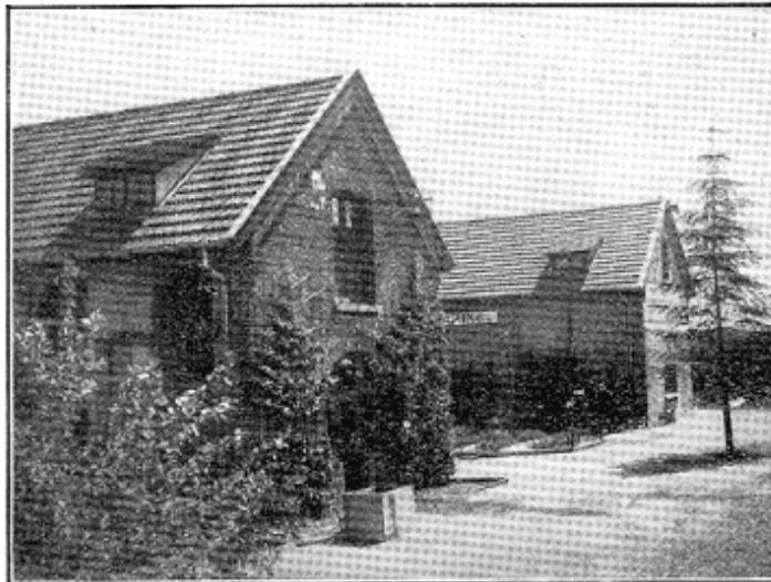
Dienstgebouwen der afdelingen « Fruithof en boomkweekerij », Rijkstuinbouwschool te Vilvoorde. De tweede vleugel van het bouwcomplex is bestemd voor fruitbewaring met koel- en gasinstallatie.
